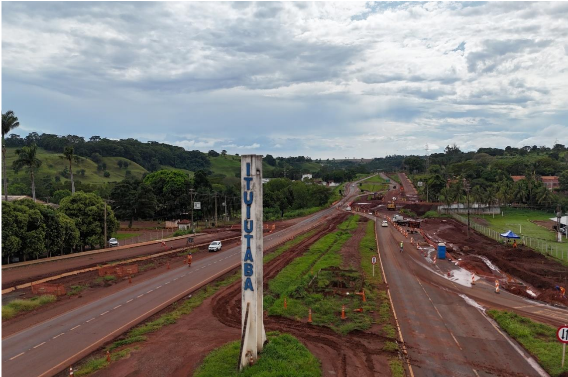
Foto aérea de obras da vicinal que dá acesso ao município de Ituiutaba - MG.
